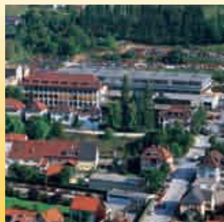
Das Werk I in Albstadt
